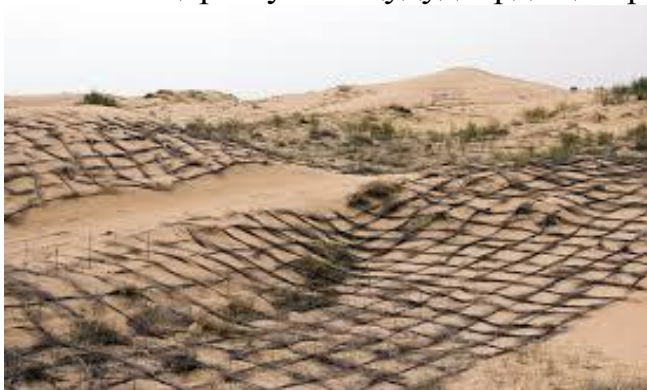
1-расм. Бархан қумликларда қамишдан ўрнатилган механик тўсиқлар ва орасига экилган саксовуллар
